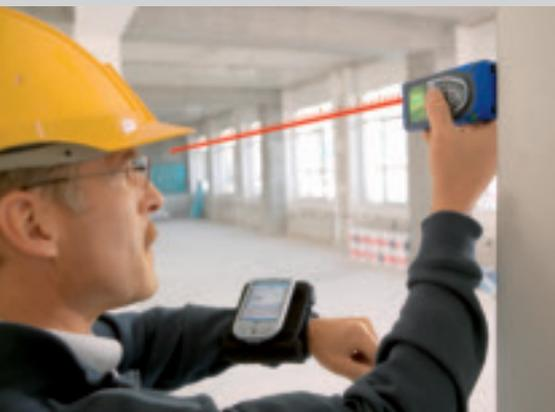
Misurazione delle distanze in pochi secondi ed elaborazione immediata con un Pocket PC o computer portatile.
